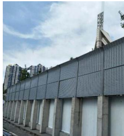
杭州中心项目·隔音屏板
